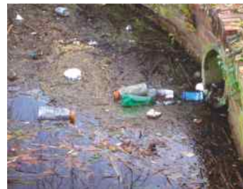
Częściowe oczyszczanie wód deszczowych
